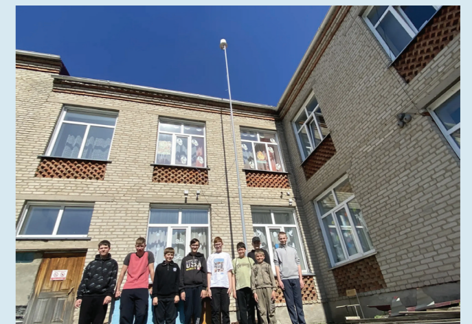
Обучающиеся центра «ИТК» Баганского района устанавливают антенну на флагштоке. Чтобы принимать сигналы спутников, она располагается выше уровня крыши
